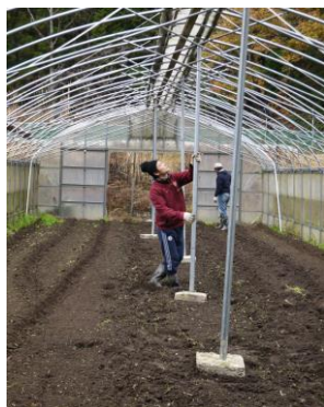
ビニールハウスの支柱立て
