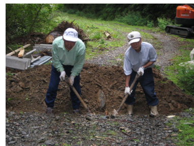
排水管の設置作業中
